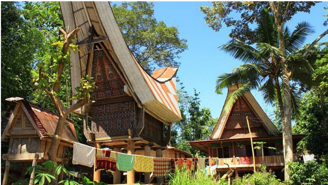
Die schiffsähnlichen, traditionellen Ahnenhäuser der Toraja nennen sich „Tongkonan“. Sie werden auf Holzpfählen errichtet und die Dächer bestehen aus Bambus.
